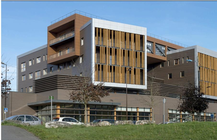
**Figure 8.** *Le siège de l'Institut technologique FCBA regroupant bureaux et laboratoires à Champs-sur-Marne. Achevé en 2014, il combine le bois lamellé, l'ossature bois et le CLT.*
