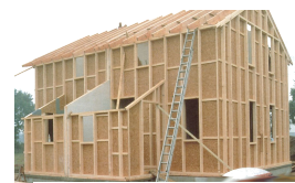
Fig 7 : charpente, ossature et panneaux de
