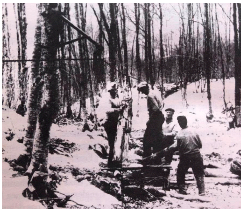
Figure 1. Plateforme de déchargement des paquets. On voit que l'opérateur de gauche va décrocher la queue de cochon sans effort, le paquet étant à l'appui sur la table de réception. Le câble arrive sur la gauche de la photo, passe sur une poulie accrochée à une potence métallique (elle-même arrimée à un arbre), dessert la plateforme de déchargement, et repart vers la droite de la photo.
