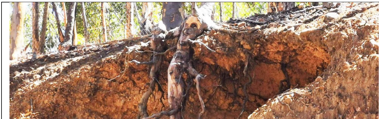
Figure 12 : érosion à Franshoek (photo H. Defrancq)
