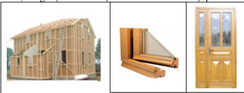
Figure 4: maison à ossature bois, huisserie et porte extérieure en moabi
